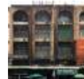
16. ตึกแถวบนถนนอุดมสุข (ซอยอุดมสุข 10)
